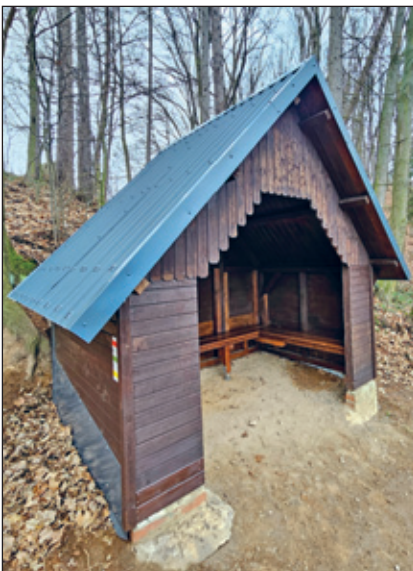
reparierte Wanderhütte in Lauenhain
