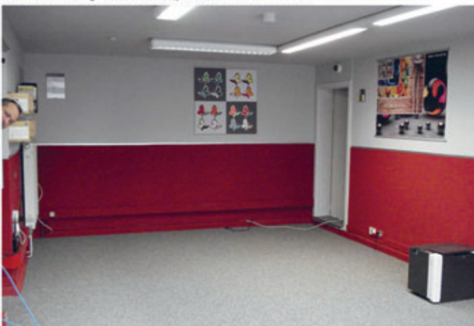
016 - Erneuerung Bodenbelag Geschäftsraum „ReproCenter Esni“
